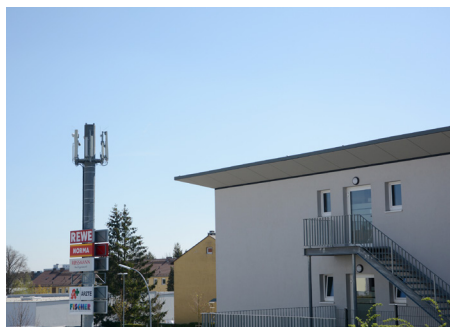
August-Mohl-Straße in Hof
