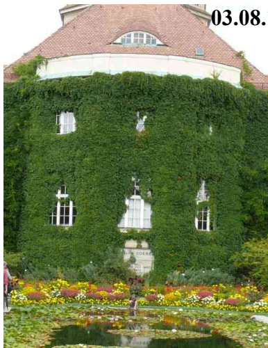
Südfassade im Funkschatten Messung: 10 \mu\text{W}/\text{m}^2
