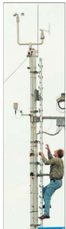
Sie prägen das Bild von Stadt und Land: Mobilfunkmasten.
